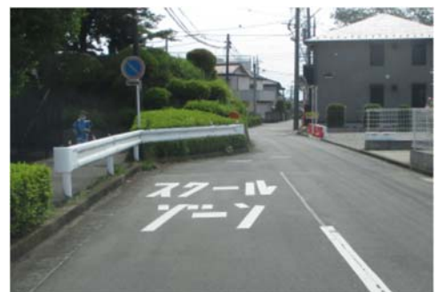
通学路 路面標示の補修
