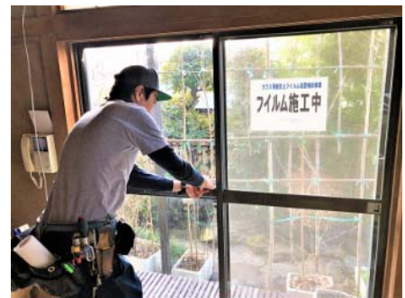
窓ガラス飛散防止フィルム 施工作业
