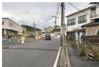
▲白根通り拡幅工事
