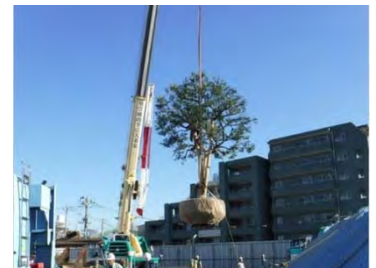
樹木の移植状況（管理棟敷地）
