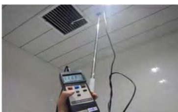
風速計による換気能力測定
