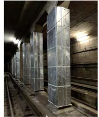
トンネル部の耐震補強工事
