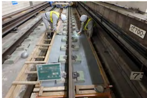
軌道改良工事
