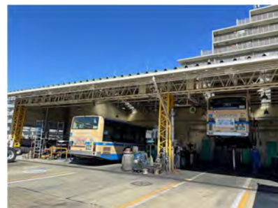
緑営業所車両整備工場
