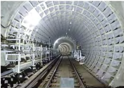
シールドトンネル補修
