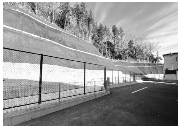
恩田東部特別緑地保全地区 ※法面は植栽基材吹付により緑化
