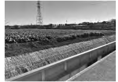
土砂流出対策を行った農地
