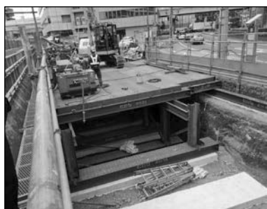
【護岸復旧工事】
