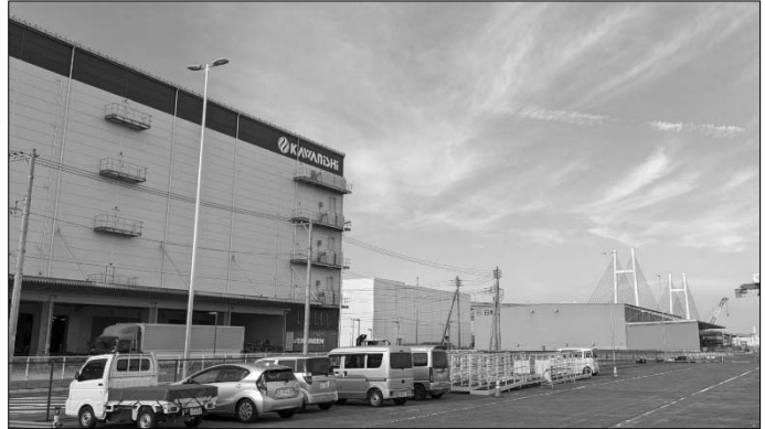
【本牧ふ頭A突堤のロジスティクス拠点】
