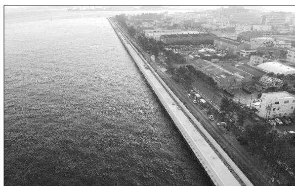
【金沢区福浦地区護岸復旧状況】
