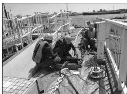
【ボンツーン係留チェーン交換】
