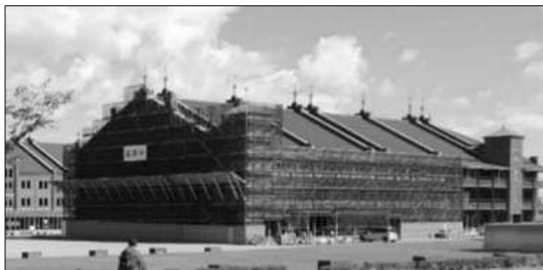
【赤レンガ倉庫の改修状況】
