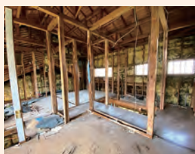
既存壁等解体
