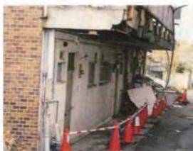
建物の痛みが著しく外壁の剥離、手すりの崩落などが見られる事例 資料：国土交通省社会資本整備審議会住宅地分科会資料
