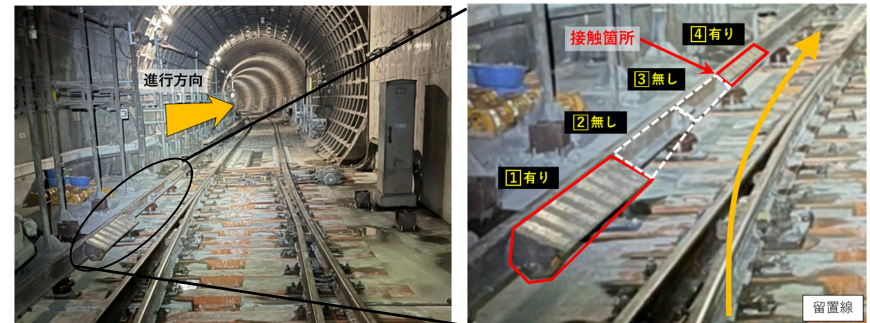
サイドインクラインの取り付け状況
