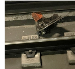
脱落した集電靴
