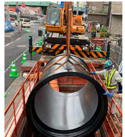
耐震管への更新工事
