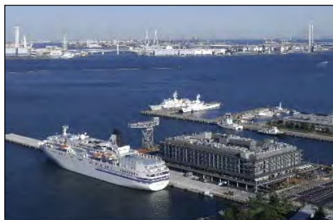
【新港ふ頭客船ターミナル】
