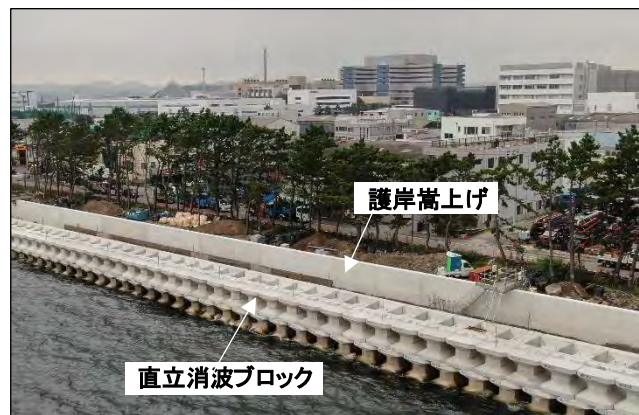
【福浦地区の復旧状況】
