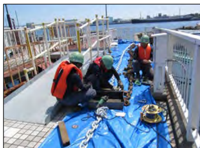
【ボツーン係留チェーン交換】
