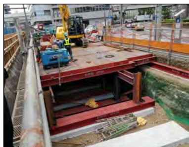
【護岸復旧工事】
