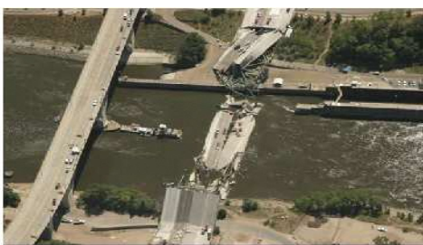
写真1 橋梁崩落事故の状況
