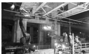
橋梁の保全工事
