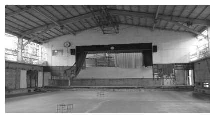
小学校体育館の改修工事
