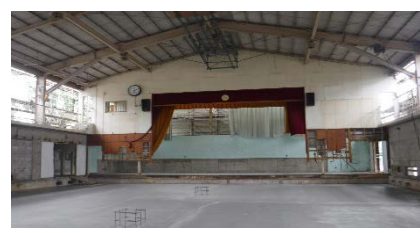
小学校体育館の改修工事
