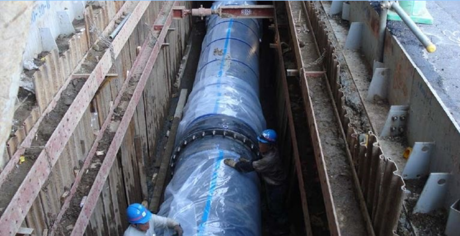
写真：水道管取替工事の様子（水道局提供）
