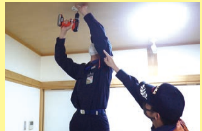
▲消防署員が取付作業をする様子
