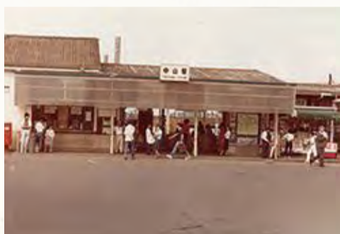
旧中山駅の駅舎は平屋構造でした。
