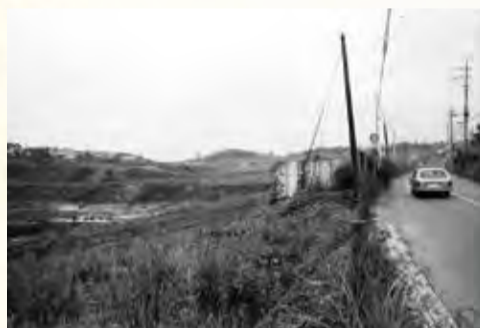
中原街道の拡幅前の様子。旭区方面を臨む。
