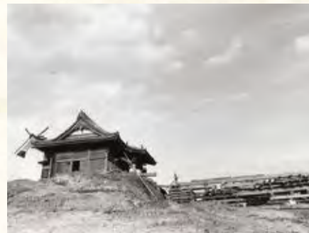
十日市場にある日向山神社が、造成工事のため高台から移動している様子。
