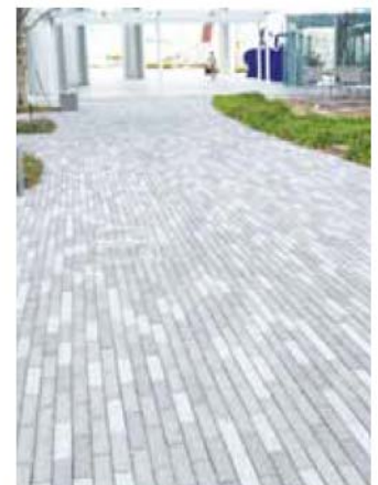
横浜三井ビルディングの透水性舗装 Permeable pavement of the YOKOHAMA MITSUI BUILDING
