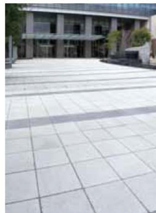
みなとみらいグランドセントラルタワーの保水性舗装 Water-retentive pavement of MM Grand Central Tower
