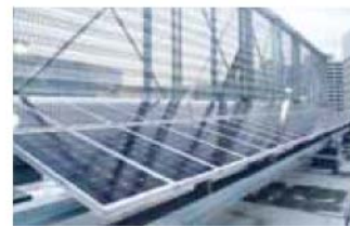
横浜アイマークプレイス YOKOHAMA i-MARK PLACE
