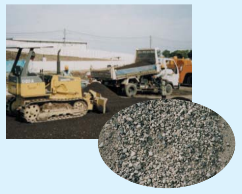
スラッグを使用した試験舗装状況 Test paving using slag
