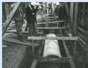
下水道の整備(1960年代) Installation of sewerage pipes (1960's)
