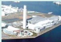
鶴見工場 Tsurumi Incineration Plant
