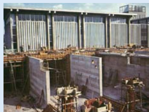
建設中の下水処理場(1960年代)(現在の港北水再生センター) Sewage treatment facility under construction (1960's)
