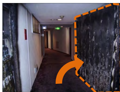
防火戸を開けた状態 ※点線部=防火戸
