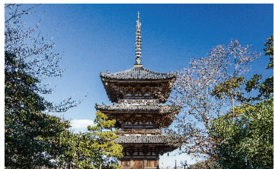
[図1-35] 旧燈明寺三重塔
