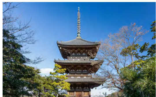
[図1-35] 旧燈明寺三重塔
