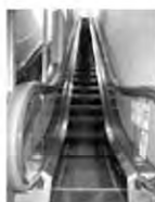
【エスカレーター/減速機の劣化】
