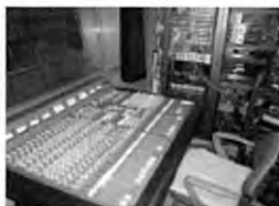
【音響調整卓/第1期工事完了】
