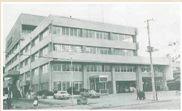
港南区総合庁舎の落成は港南区誕生から2年後の昭和46年。当時は周囲を圧倒する高さでした
