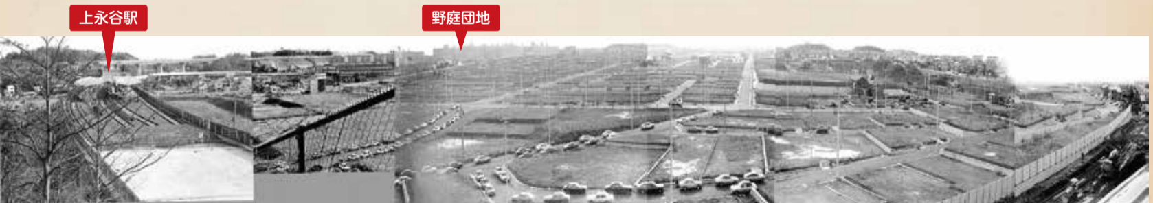
造成工事終了後の丸山台方面 (昭和54年11月に貞昌院裏山から撮影：亀野さん提供)
