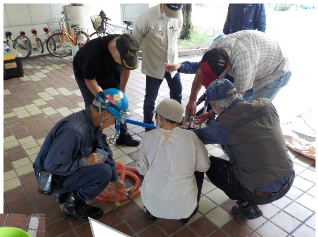
簡易給水栓の組み立て方法の確認と簡易水質検査キットの使用方法的確認
