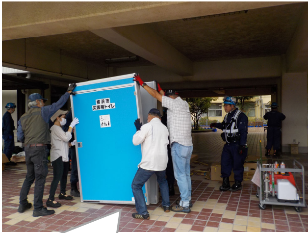
車椅子用の災害用トイレの組み立て
