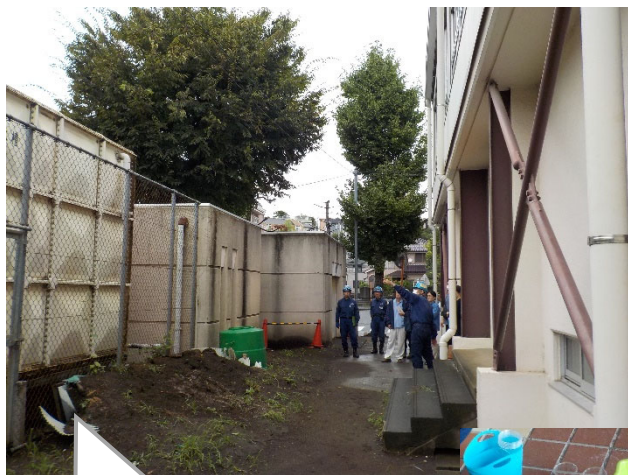
受水槽の位置と簡易給水栓の設置場所の確認
