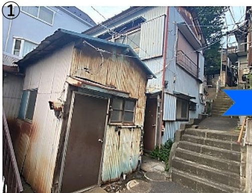
① 築50年あまりの2階建て空き家だったころの様子（1階:DK/トイレ浴室、2階:続き間の和室）
