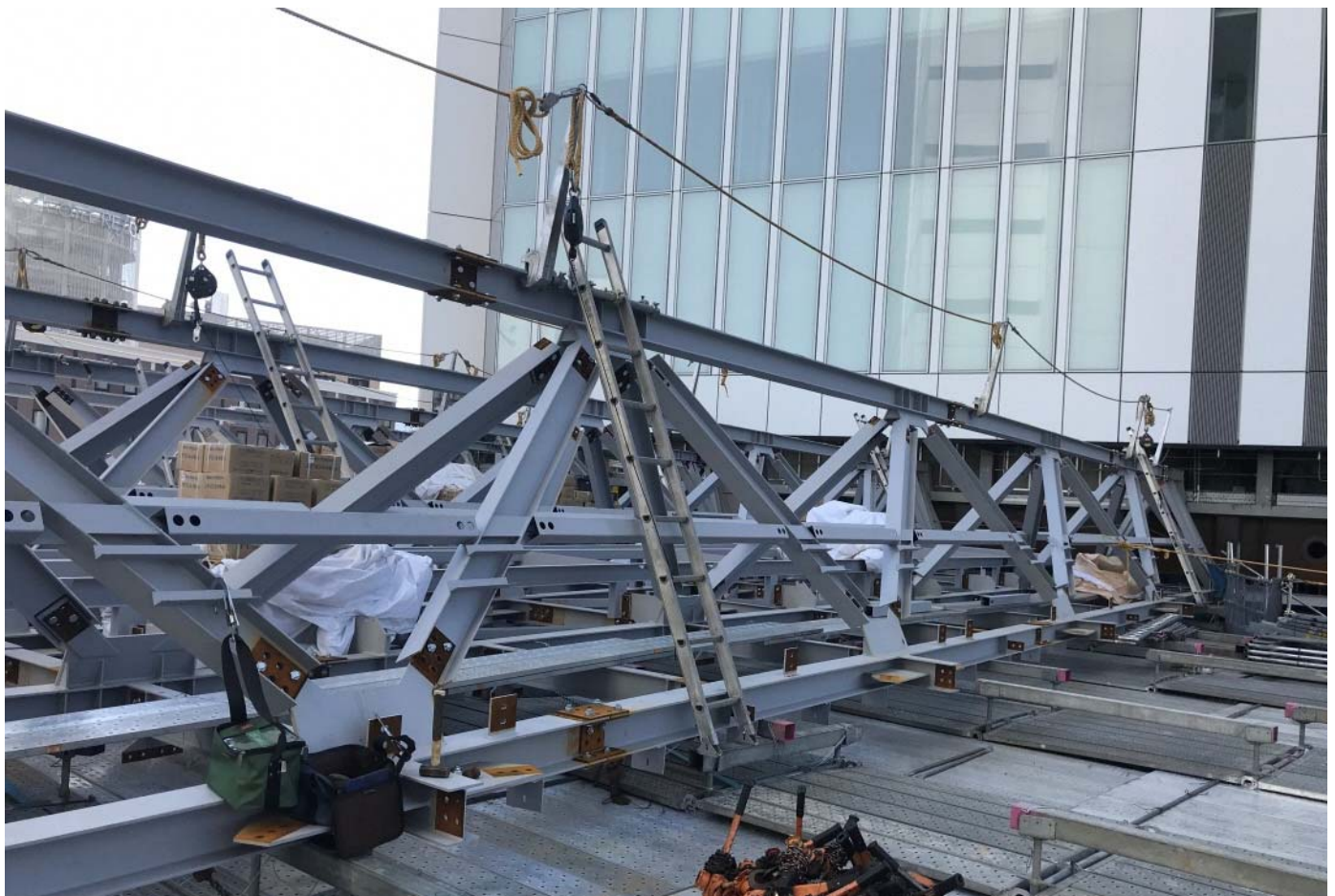
アトリウム屋根鉄骨施工状況
