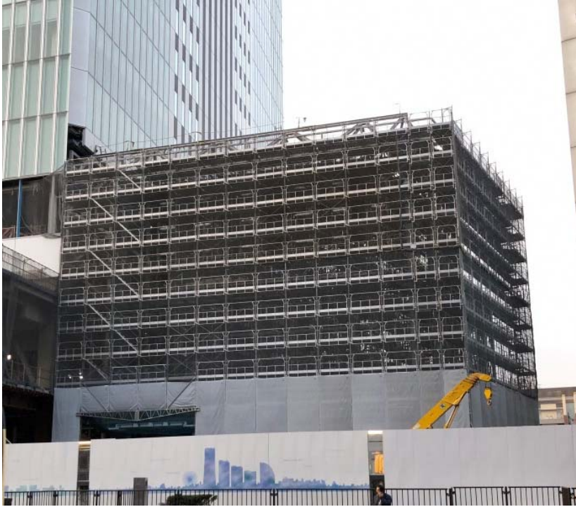
アトリウム工事全景
