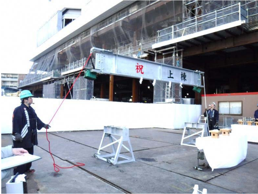
上棟梁の巻上げ
