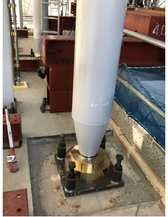
鉄骨柱の設置状況
