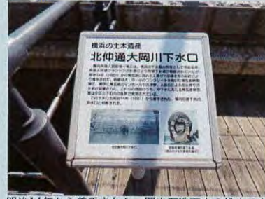
明治14年から着手された、関内石造下水の排水口と判断されるもの。
