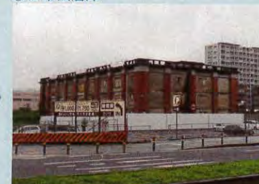
建築家・遠藤於菟の設計により関東大震災後の昭和元年に建てられた生糸絹物専用倉庫
