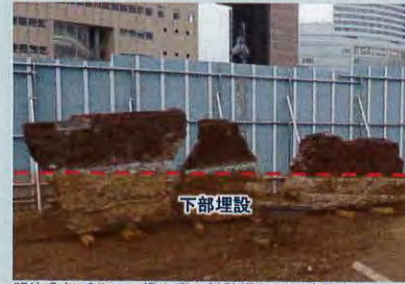
明治3年ごろに、燈台寮の試験場として建設されたレンガ造の建物基礎の一部が出土したもの。
