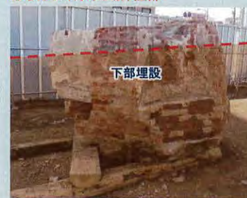
現在の横浜銀行協会・旧横浜銀行集会所の前身にあたる建物で、明治38年に建設され、関東大震災で被災・倒壊したものの柱部。
