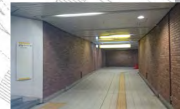
【馬車道駅市庁舎接続部コンコース】
