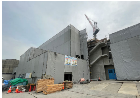
工事中の写真（令和6年2月撮影）
