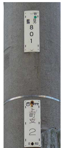
東京電力も使用しているNTT柱
