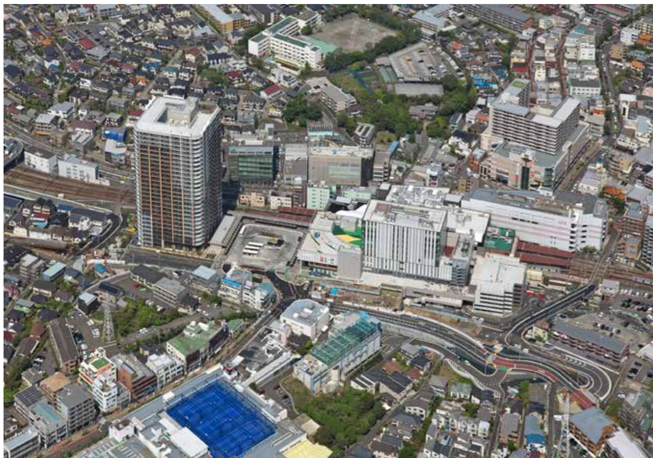
空から見た二俣川駅南口再開発地区
