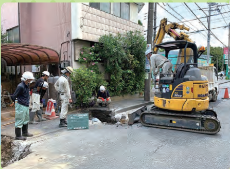
下水道敷設工事
