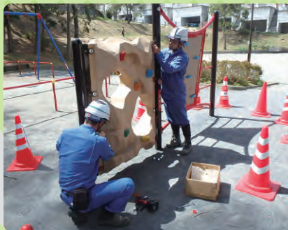
遊具を安全に使えるよう、点検・整備しています
