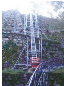
竹田城跡 石垣改修工事
