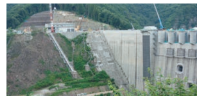
ハツ場ダム全長65m設置
