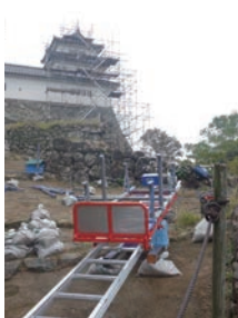
彦根城改修工事
