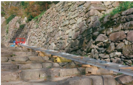
安土城跡、石垣改修工事
