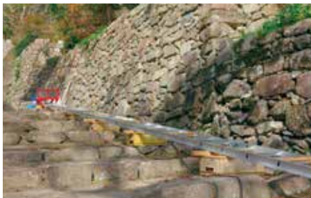
安土城跡、石垣改修工事
