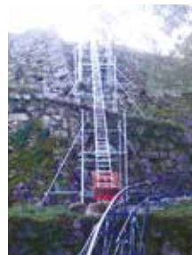
竹田城跡 石垣改修工事
