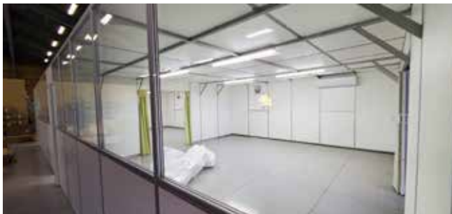
(株)コーケン様倉庫内断熱空間造作
