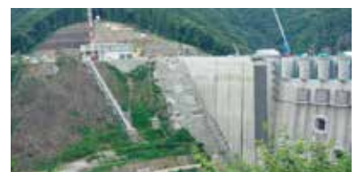
ハッ場ダム全長65m設置
