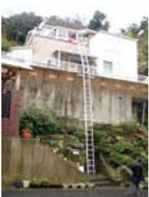
高台の家への設置
