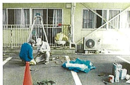
地域ボランティアによる修繕(塗装作業)
