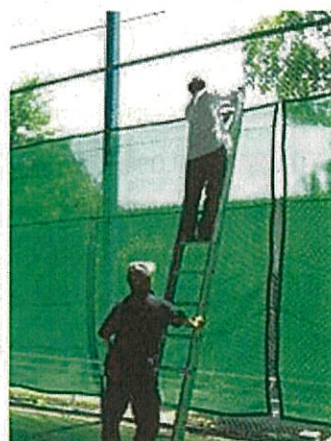
スタッフによる遮光ネット修繕
