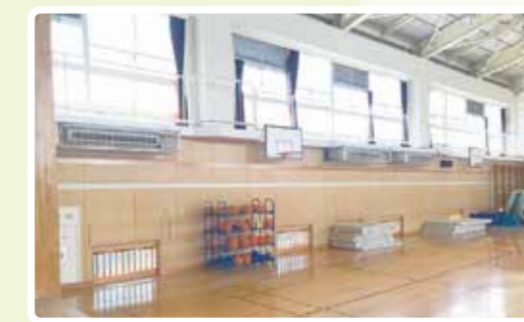
空調整備後の市立山田小学校体育館
