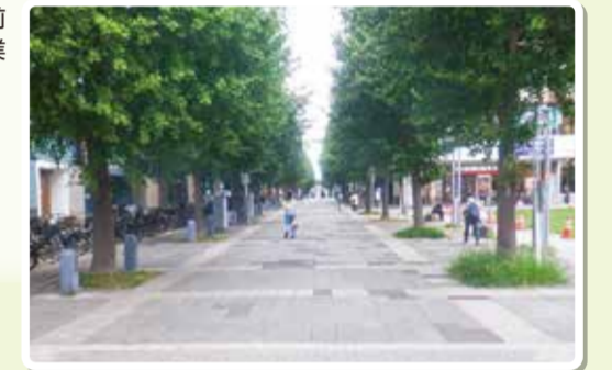
センター北駅前舗装更新事業
