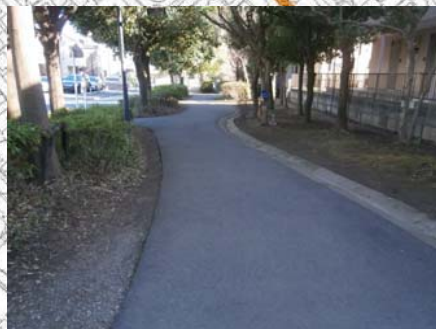
アスファルト舗装
