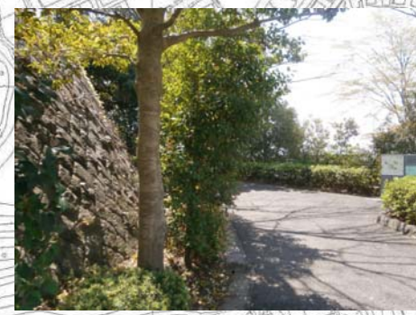
見通しが悪い 見通しが悪く、接触事故の危険性がある。
