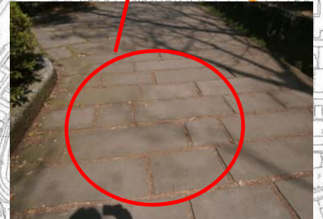
白河石舗装(目地埋めなし)
