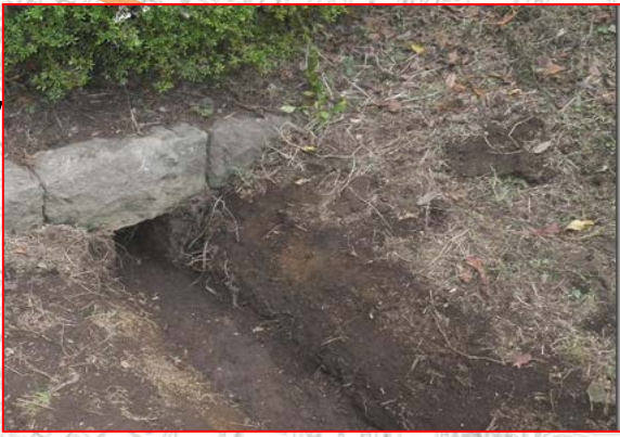
側溝の清掃 側溝に堆積している土を清掃する。(各所共通)イメージ
