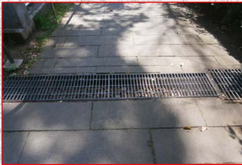
横断溝の平坦化 横断溝を改良し、グレーチングふた掛けを行い、平坦化し段差を解消する。(各所共通)イメージ
