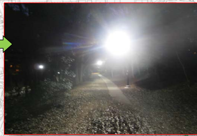
灯具のLED化 灯具をLEDに交換し、暗い場所の解消、省電力、長寿命化を図る。
