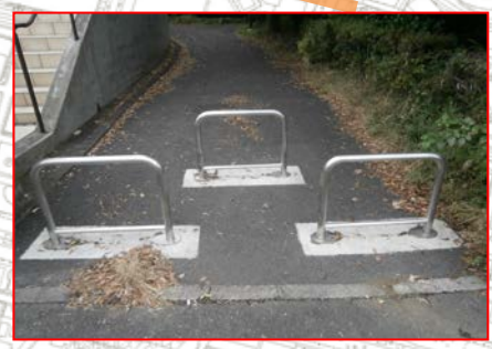
車止め 標準的なタイプの車止めを設置し、間隔は基準に適合させる。イメージ
