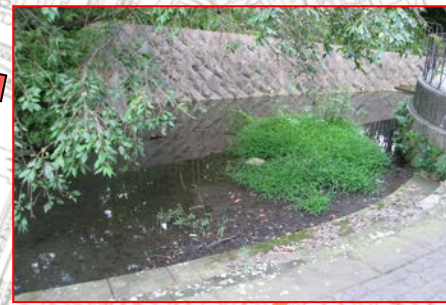
土の堆積 池の中に土が堆積して草が生えている。
