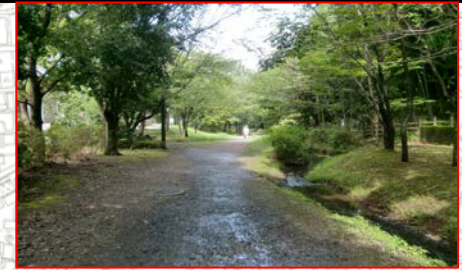
土舗装 水たまりができています。
