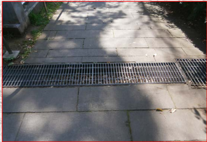
横断溝の平坦化 横断溝を改良し、グレーチングふた掛けを行い、平坦化し段差を解消する。(各所共通)イメージ
