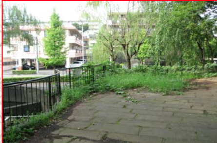
土の堆積 斜面上部から土砂が流れ堆積している
