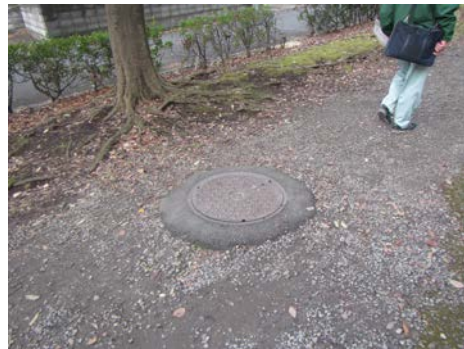
現況のマンホール蓋の状況
