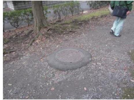
現況のマンホール蓋の状況
