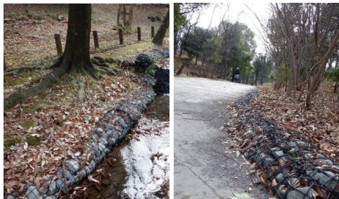
ささぶねのみち(他エリア)で設置済みのじゃかご（同仕様）
