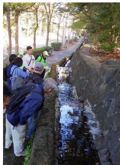
●流れの護岸補修についての説明
