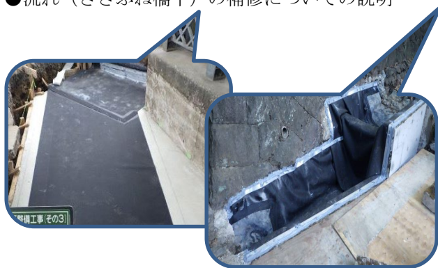
●流れは一部を一度外して、防水してから復旧しています（写真で説明）。
