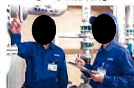
【工事完了確認の立会い】
