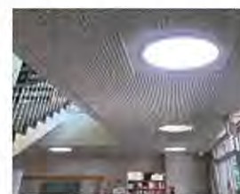
丸型LED照明更新
