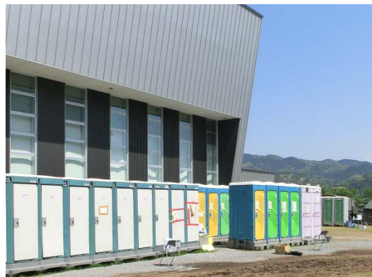
汲み取り式の仮設トイレ設置状況 (熊本県益城町の避難所)
