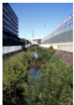
▲宮下橋付近～羽沢橋付近
