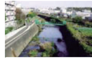
▲大山跨線橋より上流を望む
