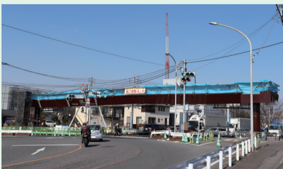
▲不動坂交差点歩道橋の工事 (2023年3月撮影)
