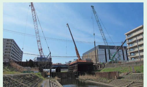
▲高島橋の架け替え工事 (2023年3月撮影)
