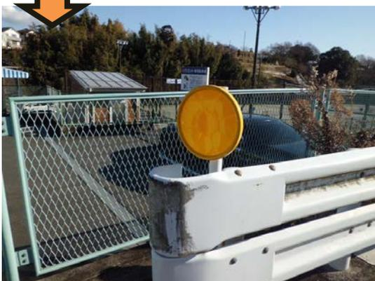
破損しているガードレールの反射板を撤去し、新しい反射板に付け替える作業を行いました。作業後は写真のとおり補修することができました。
